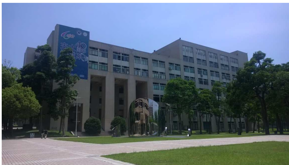
Obr. 1 Budova katedry strojního inženýrství.
